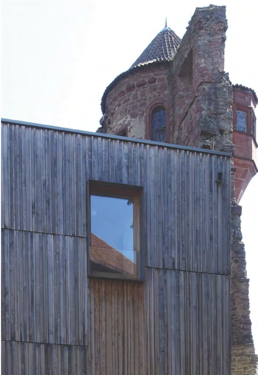
Burg Wertheim · Blick aus dem Neuen Archiv (140 qm große Ausstellungsräumlichkeiten über zwei Ebenen)
